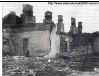
Разрушенный жилой дом.
